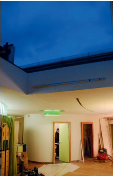
Frischluft- und Gerätezufuhr durch das offene Dach
